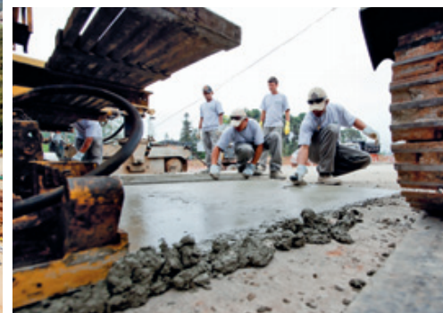
Pavimentação de estradas
