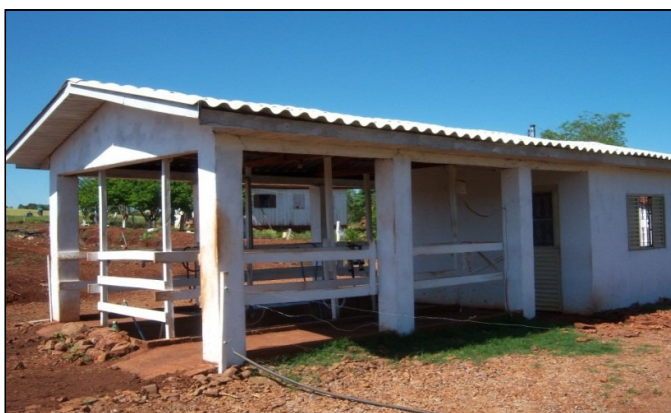
Figura 08: Nova sala de ordenha da UD 10 Fonte: Elaborado pelo autor
